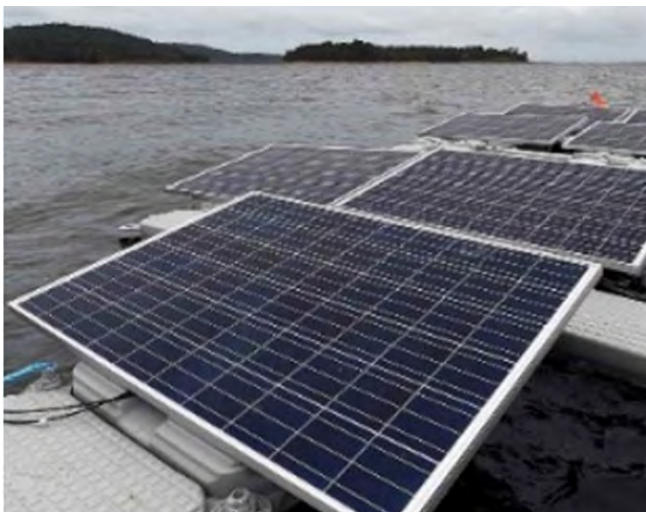
Rajah 1 Panel PV yang terapung atas permukaan air dan yang dipasang atas tanah
