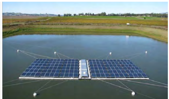
Rajah 8 Gambaran sistem bottom anchoring (kiri) dan gambar sebenar sistem bank anchoring (kanan)
