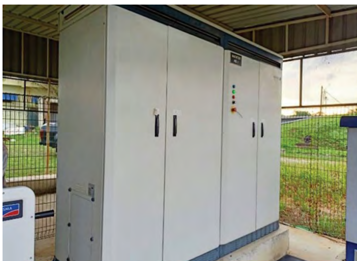
Rajah 2 Central inverter berpusat ladang solar atas tanah dan atas permukaan air
