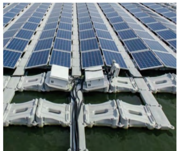
Rajah 2 Central inverter berpusat ladang solar atas tanah dan atas permukaan air
