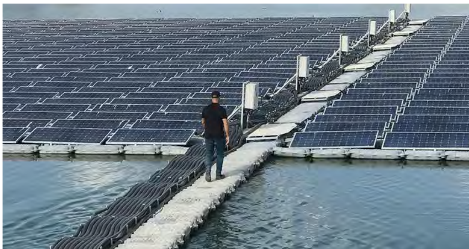
Rajah 12 Laluan terapung ( floating walkway ) untuk ladang solar terapung
