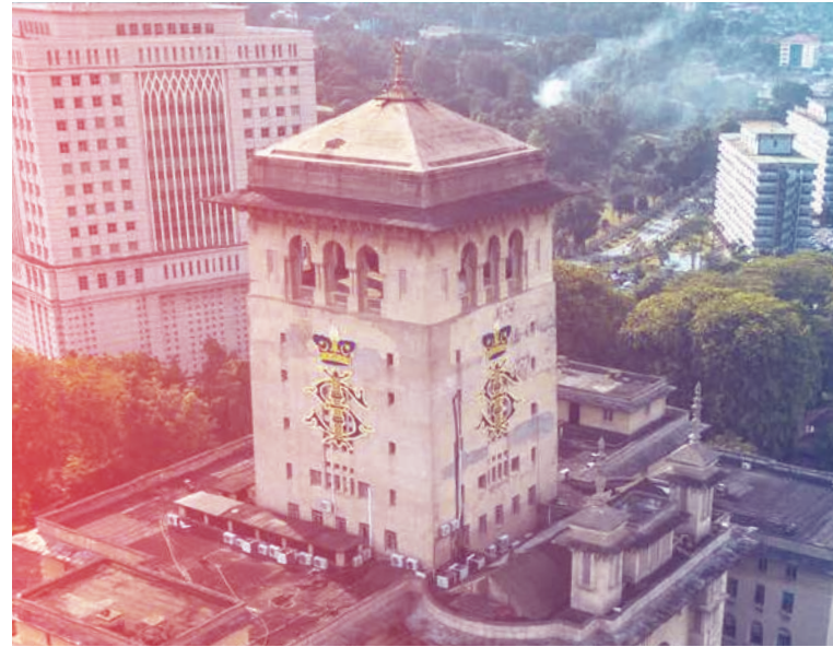
Bangunan Sultan Ibrahim, Johor Bahru
